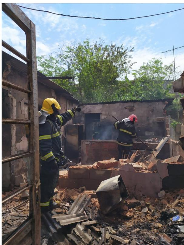
A residência era toda de telhas de amianto e engradamento que ficaram comprometidos. As paredes ficaram muito queimadas, não suportaram ao calor excessivo e algumas vieram a desabar e outras, por precaução dos bombeiros, tiveram que ser demolidas para evitar novos acidentes.
