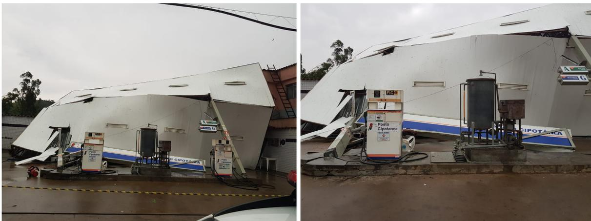
As pilstras de ferro e concreto não suportaram aos ventos de cerca de 100 km/h, vindo a desabar e trazendo consigo o forro de PVC e o telhado de zinco e ferro. O posto possui duas bombas, dotadas de gasolina/etanol e diesel.
