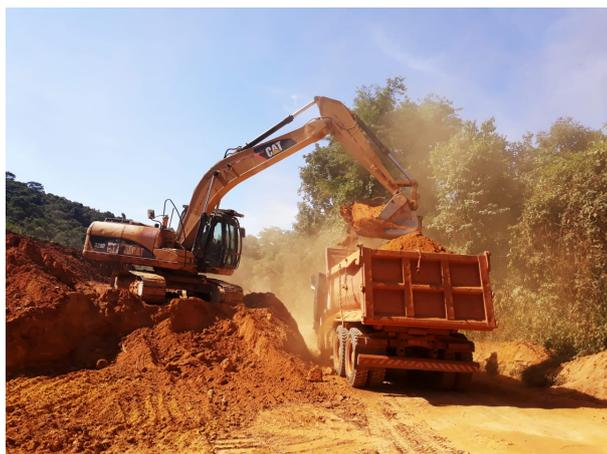
As obras na Rodovia da Batata avançam. São realizados os serviços de limpeza, escavação para a abertura da rodovia. Também está em execução o serviço de cercamento com remoção e realocação, de acordo com a necessidade da obra. A próxima etapa será a preparação de subleito para lançamento de base para pavimentação.
